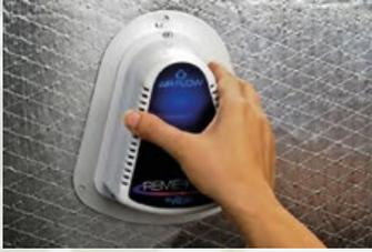
Le REME HALO offre un système de fixation rapide pour retirer l'unité, permettant ainsi un remplacement facile de la cellule PHI.
